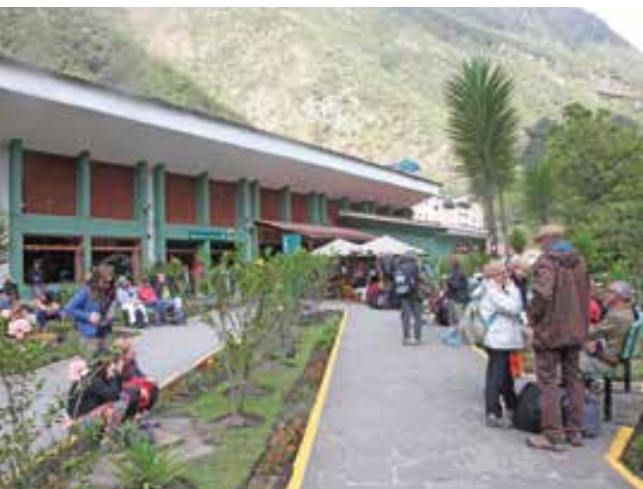
Jernbanestationen i Aguas Calientes.
